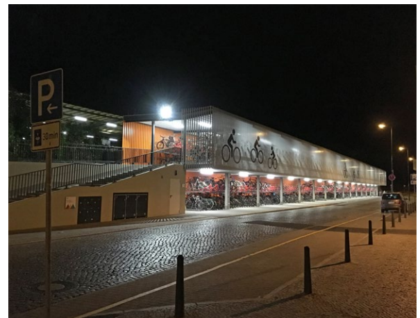
Gut beleuchtetes Fahrradparkhaus
