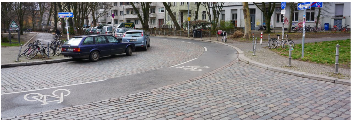
Asphaltstreifen für den Radverkehr
